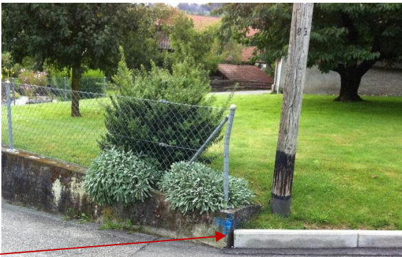
Montag 25. August 2014 Bolzen in Mauer Versicherungspunkt für Abstecknagel Schacht Neu 3.80 m
