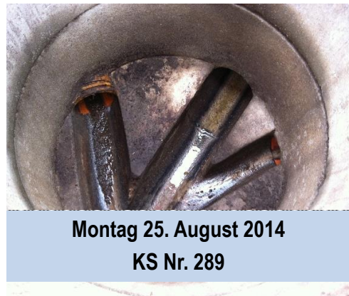
Montag 25. August 2014 Bolzen in Mauer Versicherungspunte gem. Detail-Plan
