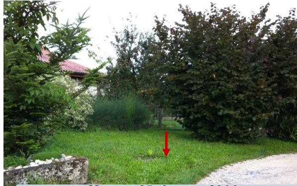
Montag 25. August 2014 Schacht Nr. 289 Startgrube für DW P-80 zum Cracken
